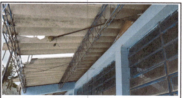
Foto 6: Reparación de Cableado eléctrico
