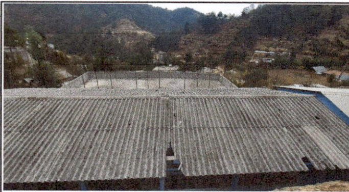
Foto 3: Sustrucción de elementos de fijación
