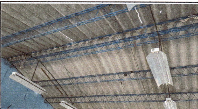
Foto 5: Sustrucción de lámparas tipo LED
